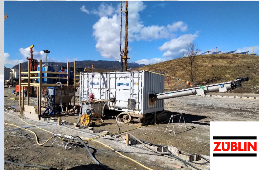
➤ GHT 390_ Baustelle Villach Zentrum 2019 (Züblin)
